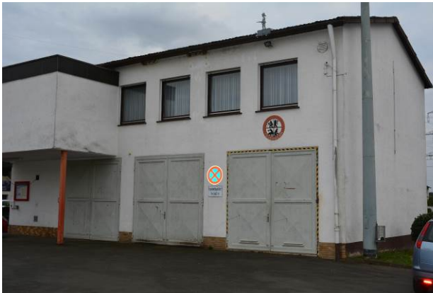
Abbildung 20 - Feuerwehrhaus Hassenhausen (rechtes Tor)
